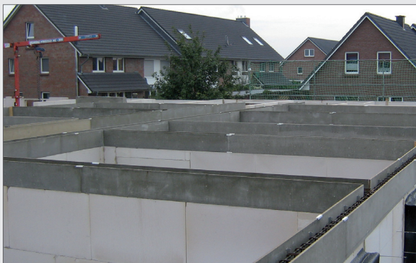
Ringankerschalung ELMCO – DIS
