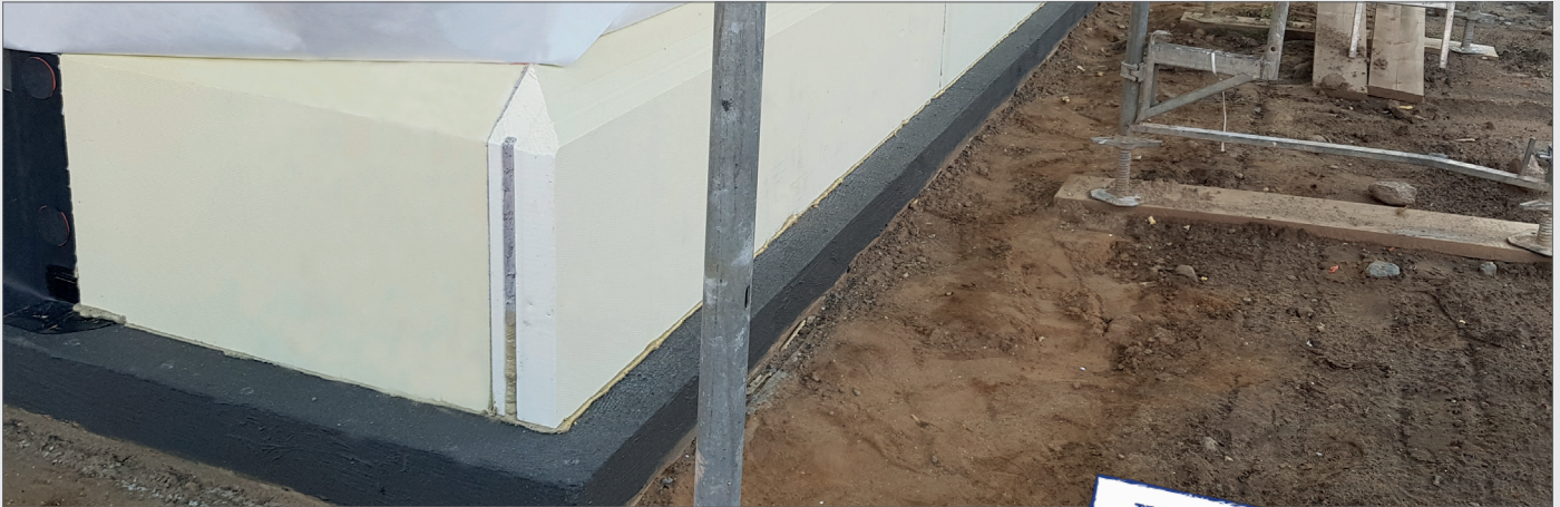
Einbaubeispiel Gefällekeil ELMCO – GK
