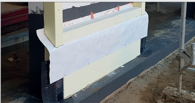
Einbaubeispiel Gefällekeil ELMCO – GK mit aufgelegtem Winkelabschnitt
