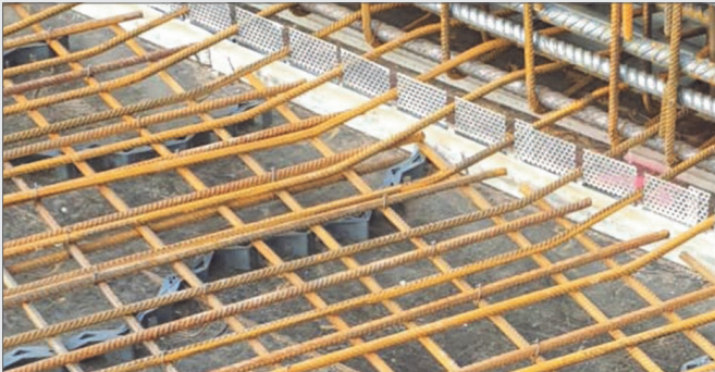
Einbausituation auf der Baustelle vor dem Verlegen der eigentlichen Arbeitsfugenabschalung
