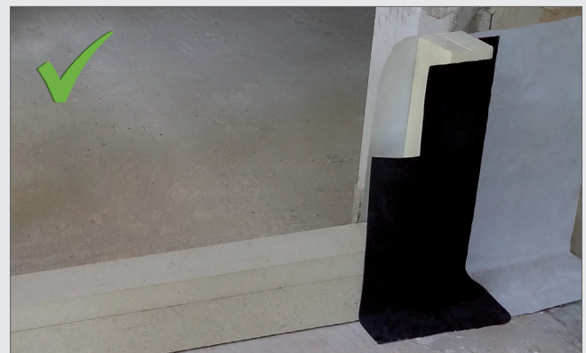
Der komplizierte Übergang der Sockelabdichtung im zweischaligen Mauerwerk im Bereich von bodentiefen Öffnungen kann sicher und normgerecht mit ELMCO – FPAE hergestellt werden.
