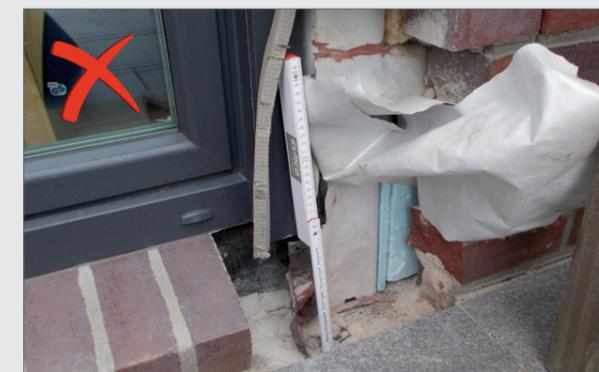
Fehlerhafte Ausführungen der Sockelabdichtung führen zu erheblichen Schäden und ziehen oft aufwändige und teure Sanierungsmaßnahmen nach sich.
