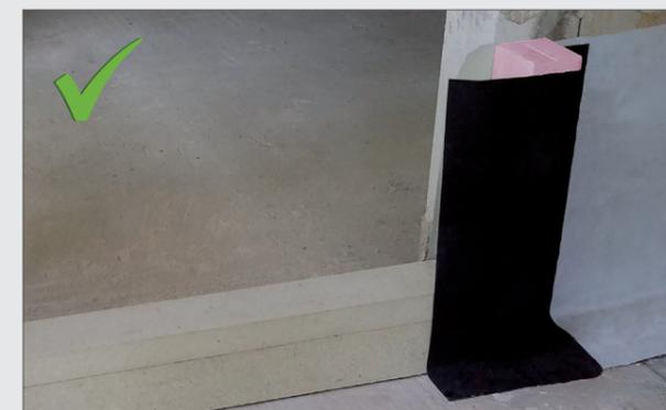
Der komplizierte Übergang der Sockelabdichtung im zweischaligen Mauerwerk im Bereich von bodentiefen Öffnungen kann sicher und normgerecht mit ELMCO – FPAE II-XPS hergestellt werden.
