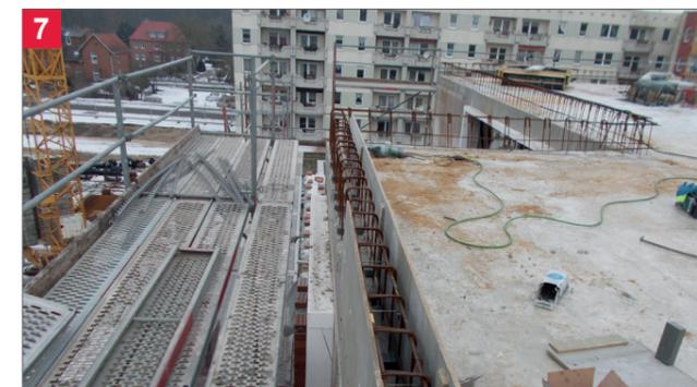
7 Zwischenbügel einsetzen
