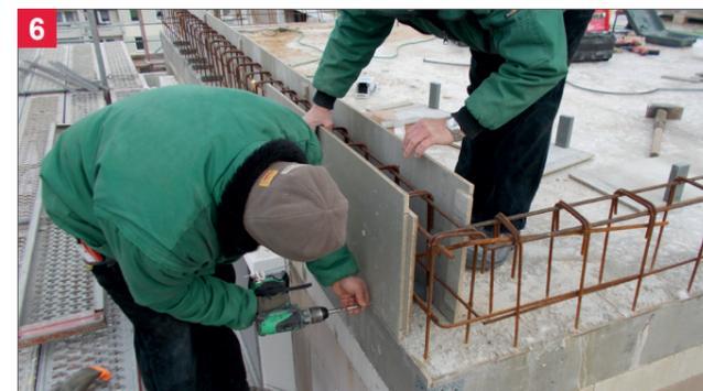
6 Zweites Seitenteil einsetzen und verschrauben
