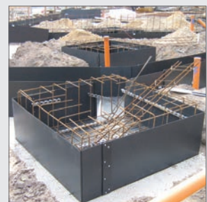
ELMCO – Form Typ FSS-U mit Blockfundament
