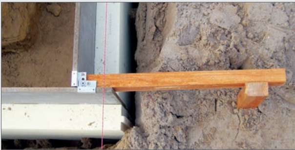
ELMCO – Form Typ FSS-I-DR Ecklösung mit Büsa-Aluklammer für 90°-Ecken
