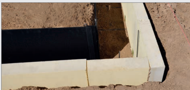
Sonderlösung ELMCO – Form Typ FSS-II-D, Ecklösung
