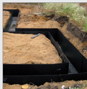
ELMCO – Form Typ FSS-U gefertigt nach Fundamentplan
