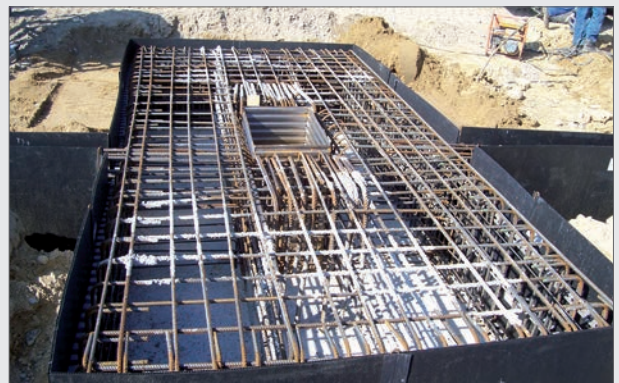
ELMCO – Form Typ FSS-E mit Fundamentköcher Typ FK
