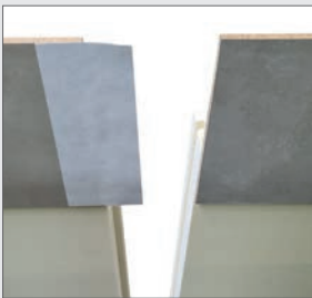
Stöße der zementgebundenen Spanplatte mit der werkseitig aufgebrachten Vliesfolie überdecken und mittels der Selbstklebung fixieren
