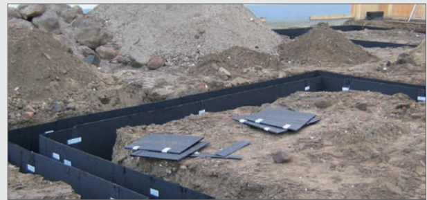
ELMCO – Form Typ FSS-II mit vorgefertigten Ecklösungen
