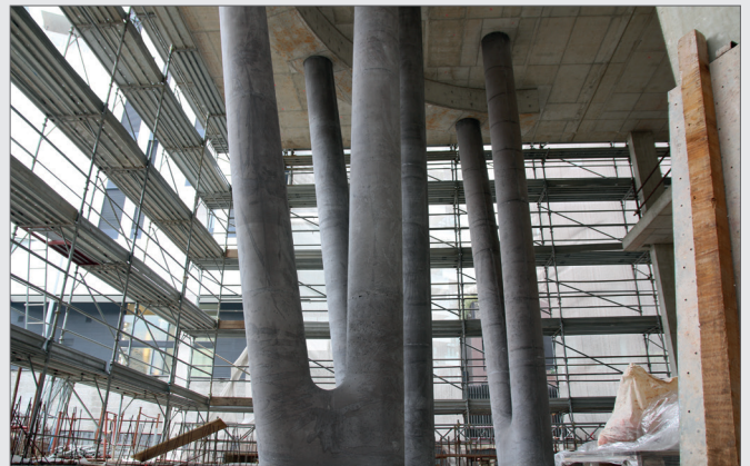
Säulenschalungen mit höchsten Sichtbetonanforderungen
