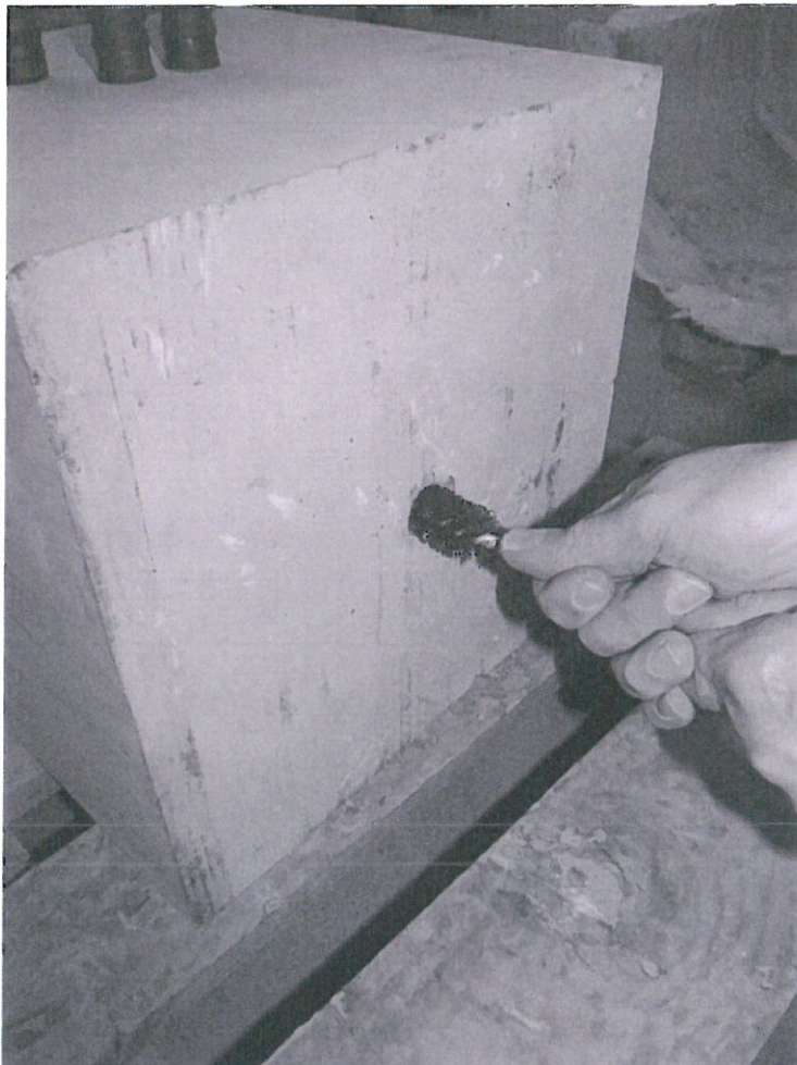
Bild 4: Reinigen der der Innen- wandung der Mauerstärken
