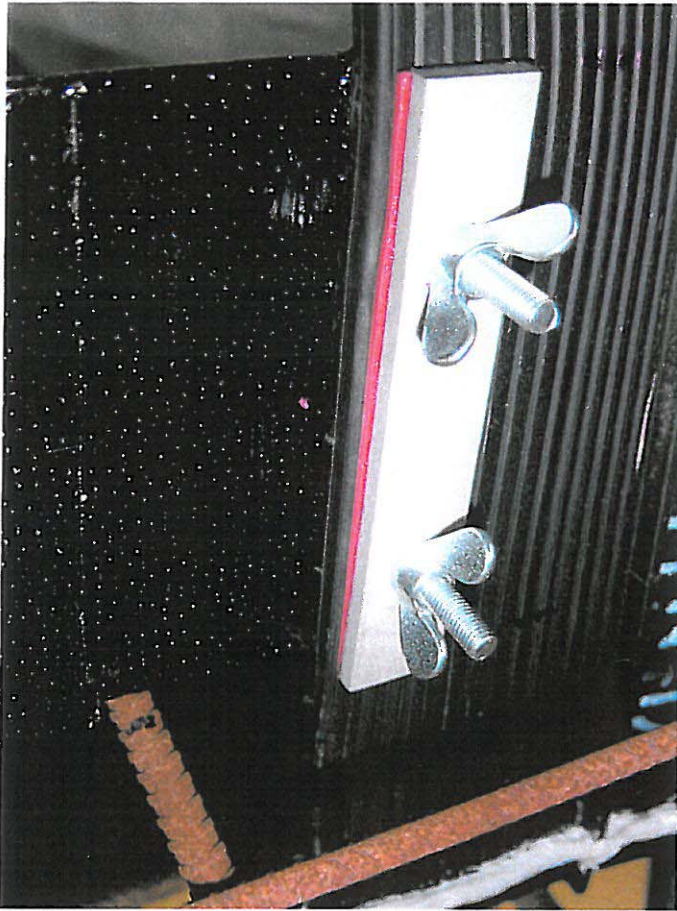
Bild 12: ELMCO-DF/AF - Fugenelement zur Verbindung von Fugenblech und Fugenband
