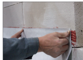
ELMCO – Sperrfolie-Vlies II' in den Kleber drücken und zusätzlich mit einer Andrückrolle fixieren
