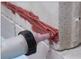
Hintermauerwerk inkl. Dämmung herstellen, ELMCO – Sperrfolienkleber auftragen
