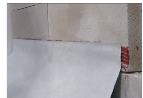
Verblendmauerwerk aufmauern und ELMCO – Sperrfolie-Vlies II' einlegen
