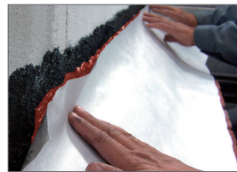
ELMCO – Sperrfolie-Vlies II' positionieren und andrücken
