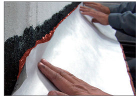
ELMCO – Sperrfolie-Vlies II 1 positionieren und andrücken
