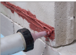
Hintermauerwerk inkl. Dämmung herstellen, ELMCO – Sperrfolienkleber auftragen
