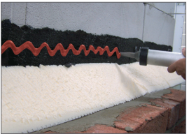
ELMCO – Sperrfolienkleber auftragen, 600 ml reichen für ca. 10 m
