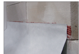
Verblendmauerwerk aufmauern und ELMCO – Sperrfolie-Vlies II' einlegen
