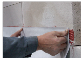
ELMCO – Sperrfolie-Vlies II' in den Kleber drücken und zusätzlich mit einer Andrückrolle fixieren
