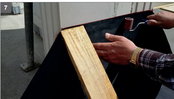
7 Mit der Andrückrolle die Klebestelle abrollen
