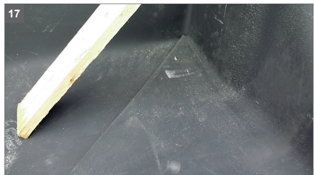
17 Bei der Innenecke wird die Folie nicht eingeschnitten sondern gefaltet
