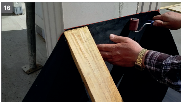
16 Mit der Andrückrolle die Klebestellen fest abrollen
