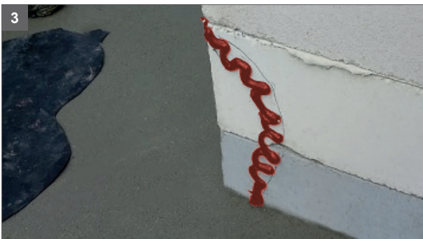
3 Auftragen des Klebers 5 cm breit in Wellenform
