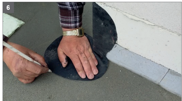
6 Mit dem unteren Teil auf der Bodenplatte verfahren wir identisch zum oberen Teil am Hintermauerwerk
