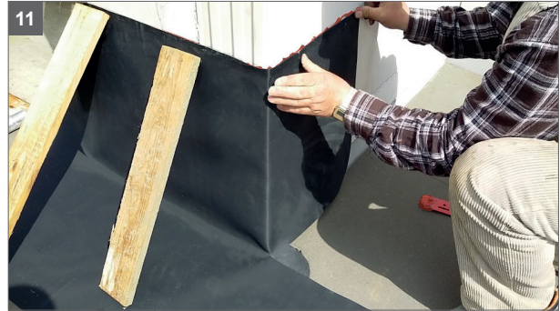
11 Folie fixieren und auf die 5 cm breite Verklebung der „8“ achten
