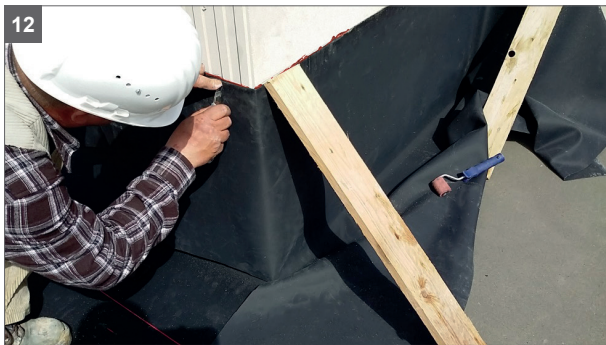
12 Zuschneiden der Bahn, eine 5 cm breite Überlappung ist ausreichend
