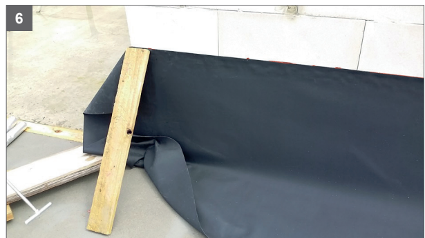
6 Temporär gegen Abrutschen sichern (hier mit einem Holzbrett)
