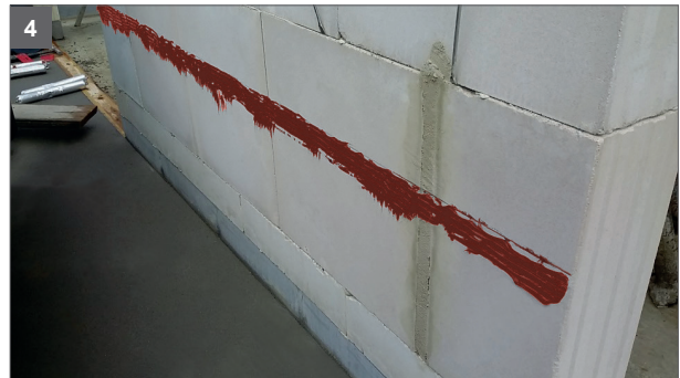
4 Mit dem Zahnpachtel den Kleber 5 cm breit verteilen
