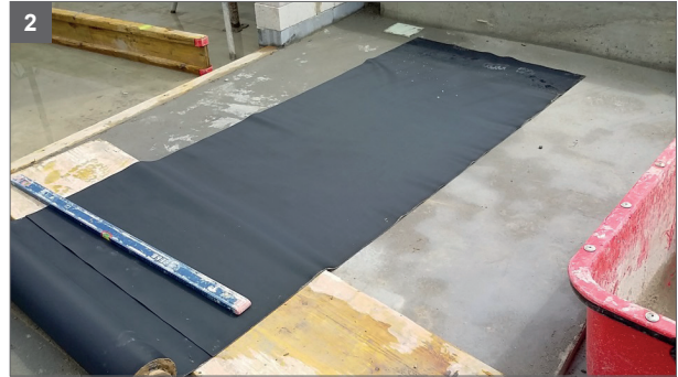
2 Ablängen der Folie, Wandlänge + Leibungsüberstand (hier 30 cm) links und rechts
