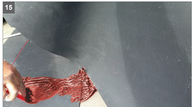
15 Mit dem Zahnpachtel verteilen, hier auf die 5 cm breite Verklebung der „8“ besonders achten
