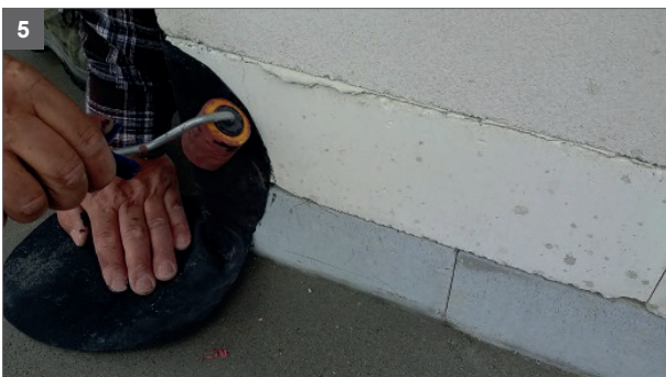
5 Mit der Andrückrolle die Folie an der Klebestelle fest abrollen
