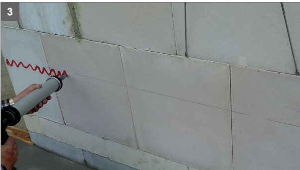
3 Auftragen des Klebers 5 cm breit in Wellenform
