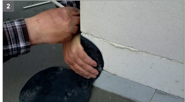
2 Anhalten der „8“ und die Lage am Untergrund markieren
