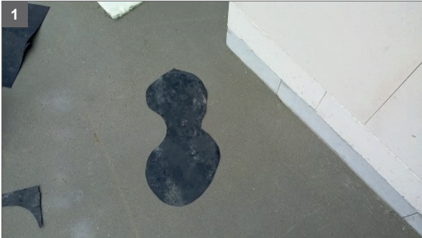
1 Eine „8“ aus einem Reststück schneiden, die schmalste Stelle muss 10 cm betragen um eine 5 cm breite Verklebung zu gewährleisten
