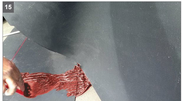
Mit dem Zahnpachtel verteilen, hier auf die 5 cm breite Verklebung der „8“ besonders achten
