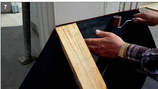
7 Mit der Andrückrolle die Klebestelle abrollen
