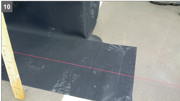
Am Übergang der aufgehenden Wand und der Bodenplatte Folie einschneiden und um die Ecke legen
