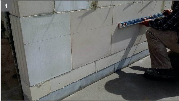
1 Anreißer der Höhe auf Hintermauerwerk, je nach Wandlänge mit Richtscheit / Wasserwaage oder Schlagschnur
