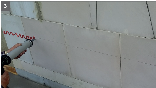
3 Auftragen des Klebers 5 cm breit in Wellenform
