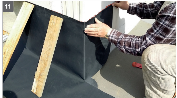
Folie fixieren und auf die 5 cm breite Verklebung der „8“ achten
