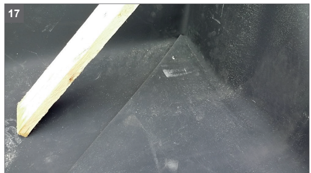
Bei der Innenecke wird die Folie nicht eingeschnitten sondern gefaltet
