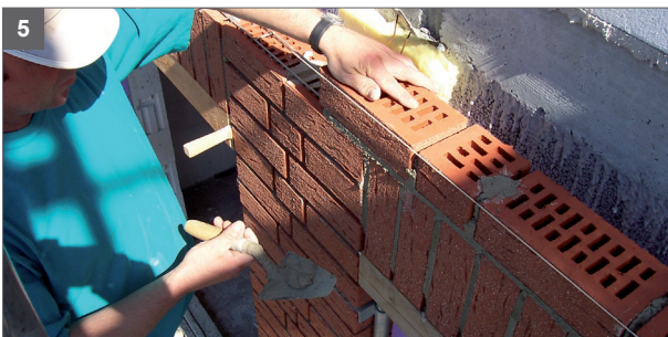
5 Läuferschichten über dem Grenadiersturz mauern
