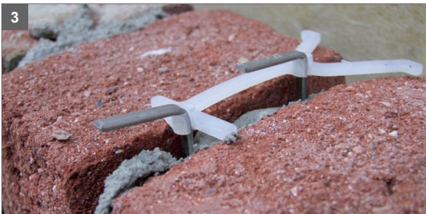
3 Der weiße Abstandhalter am Unterbügel gewährleistet einen fluchtgerechten Einbau des ELMCO – Ripp-Tragelementes.
