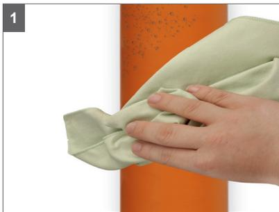
Die einzubetonierende Rohroberfläche mit einem Lappen von anhaftendem Schmutz und Schmierfilmen befreien. Der einzudichtende Rohrbereich muss eben und frei von mechanischen Beeinträchtigungen wie Rillen oder Riefen sein.
