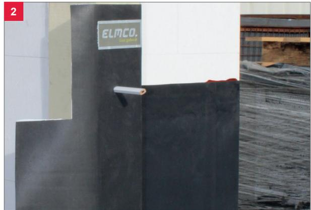
2 Das Abdichtungselement an der Leibungsinneseite bündig positionieren und Bohrlöcher für die Verdübelung anzeichnen.
