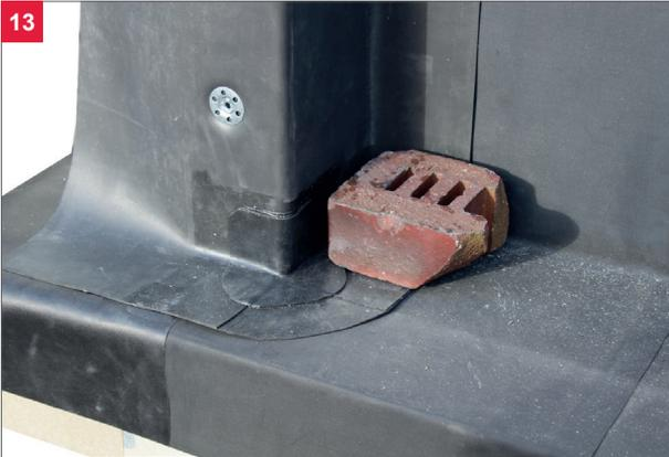
13 Den Eckbereich mit einer geeigneten Auflast bis zum Aushärten des Klebers sichern.
