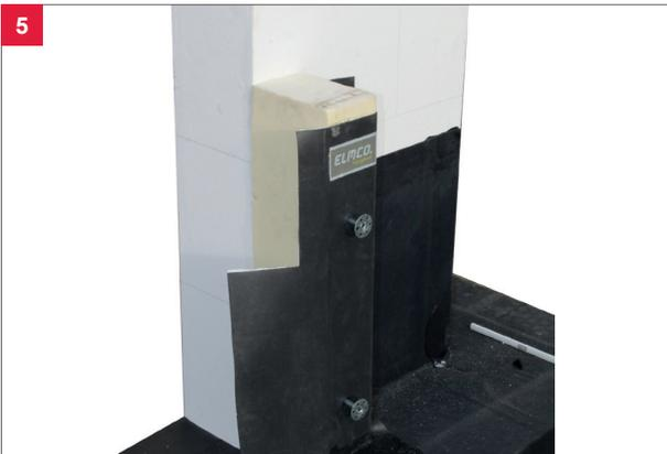
5 Das Abdichtungselement ansetzen, ausrichten und an das Hintermauerwerk andrücken.
