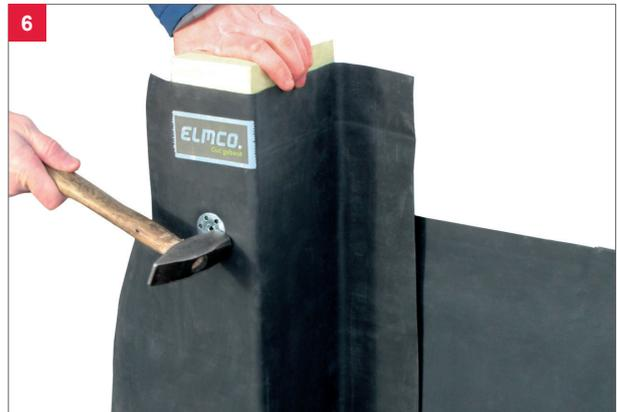
6 Dämmstoffhalter mit dem Hammer einschlagen, bis der Dämmstoffhalterter sich leicht eindrückt und etwa bündig mit der Oberfläche der Abdichtung sitzt.
