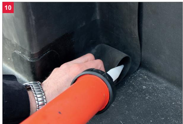
Die Innenecke einfalten (nicht einschneiden!), umlegen und mit ELMCO – Sperrfolienkleber fixieren. Zuvor die Falte selbst satt mit dem ELMCO – Sperrfolienkleber ausfüllen.
