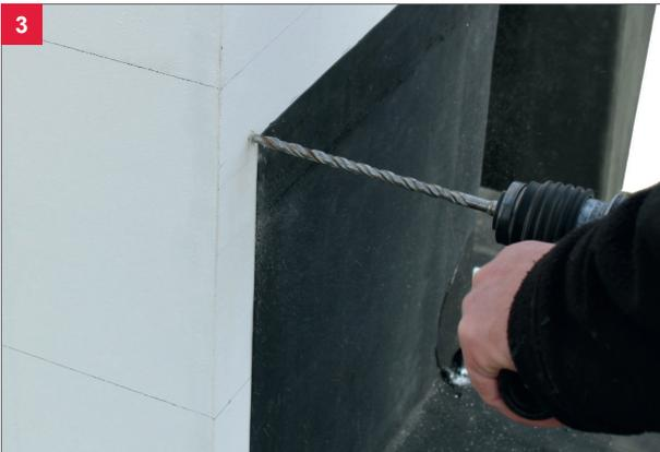
3 Löcher mit 8 mm Bohrer herstellen. (Bohrtiefe je nach XPS-Element und Dübellänge individuell wählen) Achtung: ca. 5 mm tiefer bohren zwecks Versenken der Dämmstoffhalterter! Bei Porenbeton entfällt das Vorbohren, da direktes Einschlagen in den Baustoff möglich.
