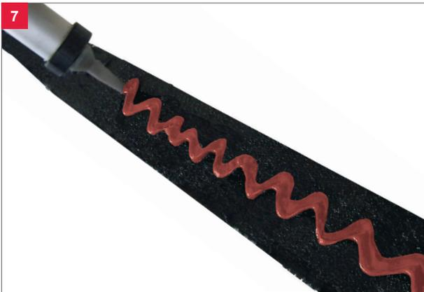
ELMCO – Sperrfolienkleber als Raupe wellenförmig auftragen...
