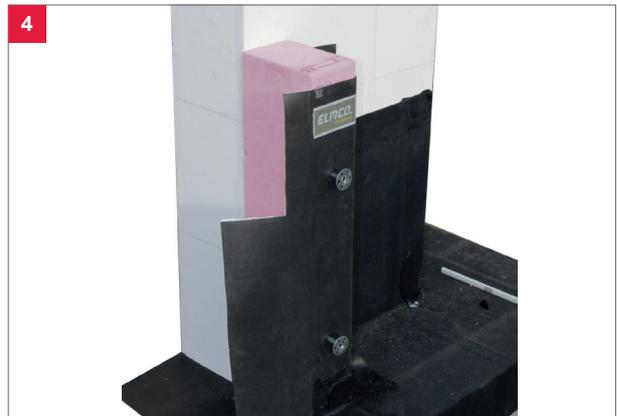
4 Das Abdichtungselement ansetzen, ausrichten und an das Hintermauerwerk andrücken.
