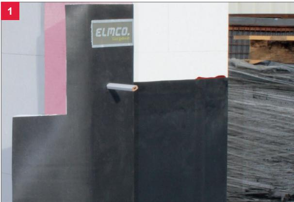
1 Das Abdichtungselement an der Leibunginnenseite bündig positionieren und Bohrlöcher für die Verdübelung markieren.
