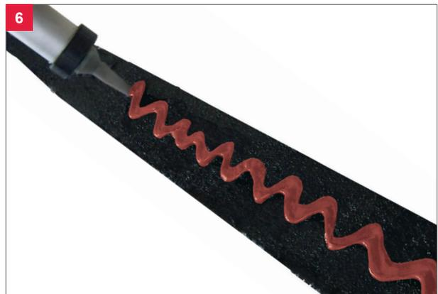
6 ELMCO-Sperrfolienkleber als Raupe wellenförmig auftragen...
