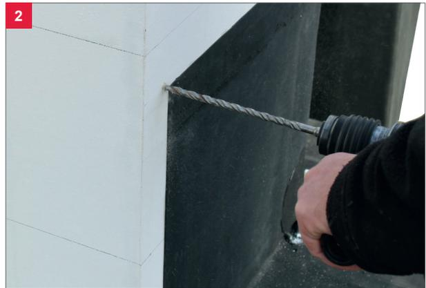
2 Löcher mit 8 mm Bohrer herstellen. (Bohrtiefe je nach XPS-Element und Dübellänge individuell wählen). Achtung: ca. 5 mm tiefer bohren zwecks Versenken der Dämmstoffhalterter! Bei Porenbeton entfällt das Vorbohren, da direktes Einschlagen in den Baustoff möglich.
