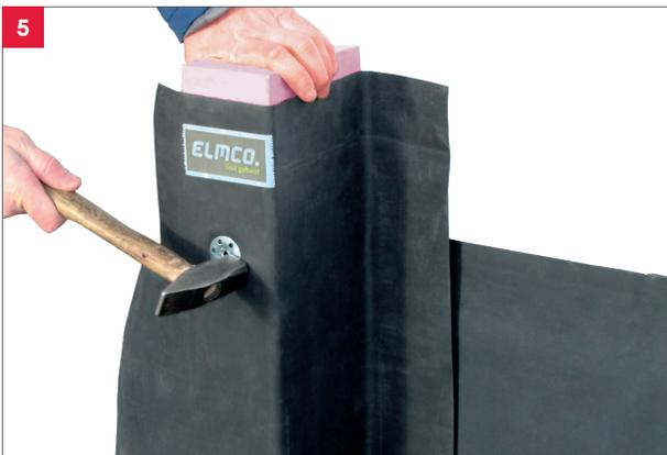
5 Dämmstoffhalter mit dem Hammer einschlagen, bis der Dämmstoffhalterter sich leicht eindrückt und etwa bündig mit der Oberfläche der Abdichtung sitzt.
