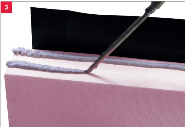
3 Rückseitig auf das Abdichtungselement PU-Schaumkleber auftragen, alternativ ist auch die Fixierung mit PMBC möglich.
