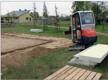
Aushub des Fundamentgrabens
