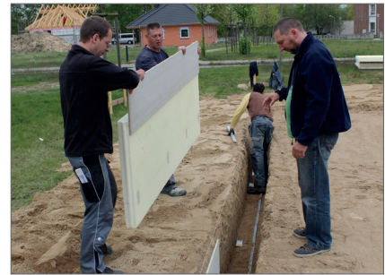
Elemente werden von oben in den Fundamentgraben gestellt und ausgerichtet
