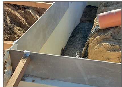
Streifenfundament lagenweise betonieren
