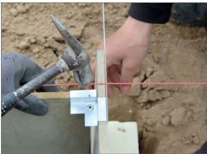
Verbinden der zementgebundenen Holz-faserplatten mit den Büsa
