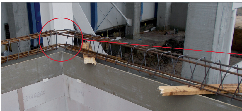
Ringanker- und Sturzbewehrung mit ELMCO – FeKo als Eckbewehrung
