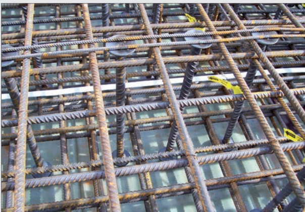
Schöck Durchstanzbewehrung Bole® - O vor dem Einbau
