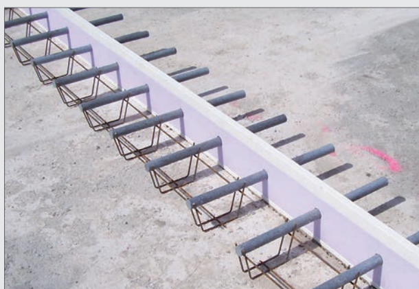
Einbaubeispiel: Dübel in Raumfuge mit schmalem Unterstützungskorb und bauseitiger Raumfugeneinlage
