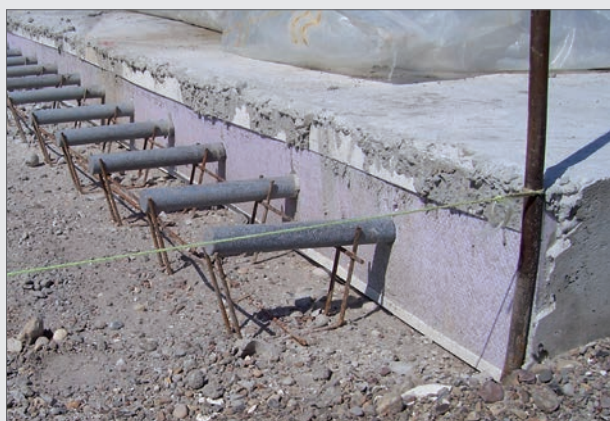
Einbaubeispiel nach dem ersten Betonierabschnitt
