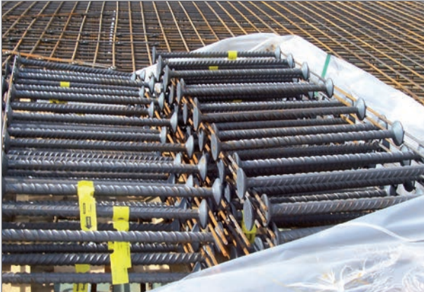
Schöck Durchstanzbewehrung Bole® - O vor dem Einbau
