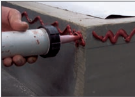
ELMCO – Sperrfolienkleber wellenförmig auftragen, 600 ml reichen für ca. 10 m
