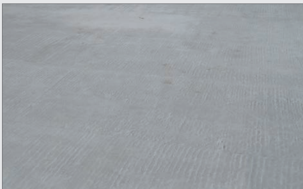
Auch bei 32 °C Lufttemperatur verhinderte Emcoril Protect M lite Risse im Beton durch zu schnelles Austrocknen, bedingt durch die starke Sonneneinstrahlung
