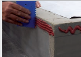
ELMCO – Sperrfolienkleber mit Zahnpachtel auf 50 mm vollflächig verteilen
