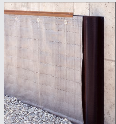
Noppenfolie mit Drainagevlies mit Randabschlussprofil befestigt als Grundmauerschutz
