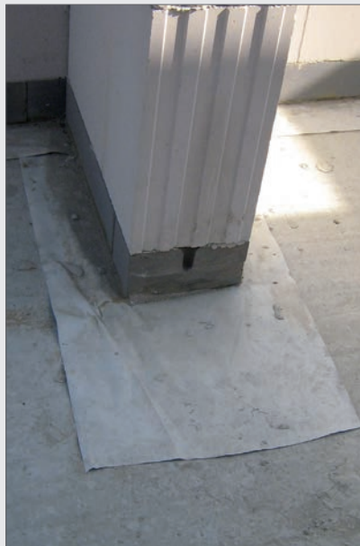
Abdichtung unter Wänden
