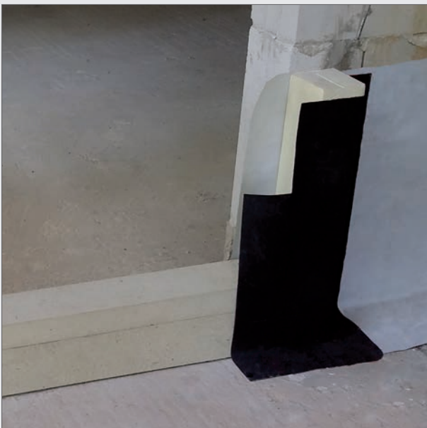
Der komplizierte Übergang der Sockelabdichtung im zweischaligen Mauerwerk im Bereich von bodentiefen Öffnungen kann sicher und normgerecht mit ELMCO–FPAE hergestellt werden.
