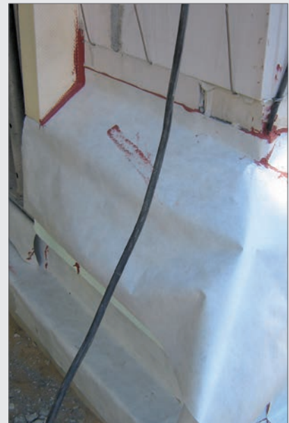
Abdichtung im zweischaligen Mauerwerk
