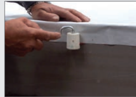
ELMCO – Sperrfolie-Vlies II 1 in den Kleber drücken und zusätzlich mit einer Andrückrolle fixieren
