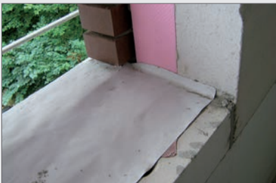
Abdichtung unter dem Fenster
