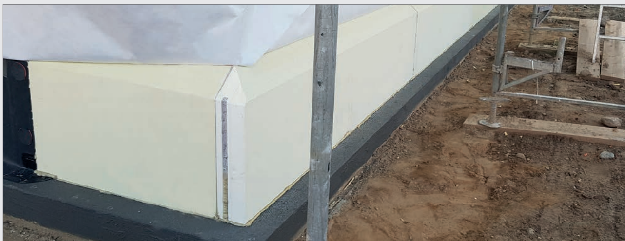
Einbaubeispiel ELMCO – GK Gefällekeil
