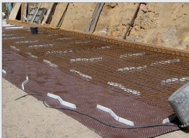
Noppenfolie als Sauberkeitsschicht unter Sohlplatten
