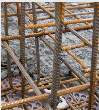
Noppenfolie als Sauberkeitsschicht unter der Bodenplatte
