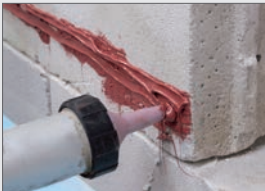
Hintermauerwerk inkl. Dämmung herstellen, ELMCO – Sperrfolienkleber auftragen
