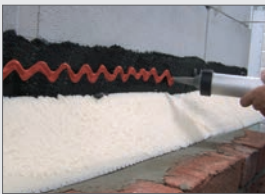
ELMCO – Sperrfolienkleber auftragen, 600 ml reichen für ca. 10 m
