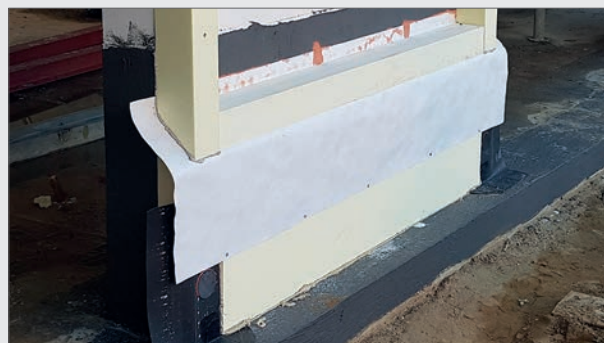
Einbaubeispiel ELMCO – GK Gefällekeil mit aufgelegtem Winkelabschnitt
