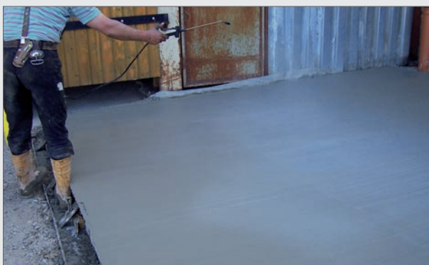
Die mit Emcoril Protect M lite behandelte Betonfläche ist während des Auftrags gut sichtbar und wird beim Trocknen transparent
