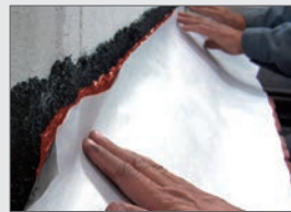
ELMCO – Sperrfolie-Vlies II' positionieren und andrücken
