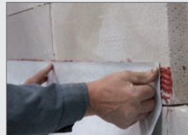
ELMCO – Sperrfolie-Vlies II 1 in den Kleber drücken und zusätzlich mit einer Andrückrolle fixieren
