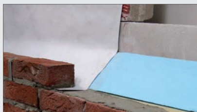
ELMCO – Sperrfolie-Vlies II, geprüfte 1 Befestigung am Hintermauerwerk
