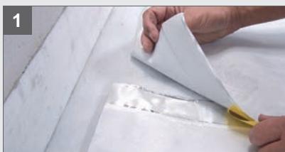
btf - Flexibel New - Feuchtigkeitssperre verlegen und die Stöße der Längsseiten verkleben
