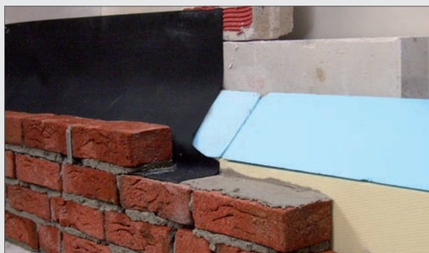
ELMCO – Sperrfolie-EPDM, geprüfte Verklebung der Stöße
