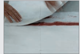
Verkleben der Überlappung mit ELMCO – Sperrfolienkleber, Ausführung wie beschrieben
