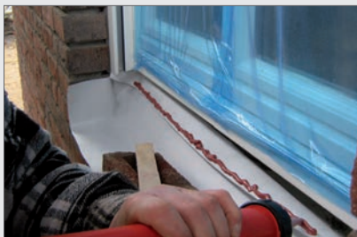
Abdichtung unter der Fensterbank
