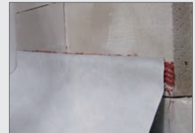
Verblendmauerwerk aufmauern und ELMCO – Sperrfolie-Vlies II 1 einlegen
