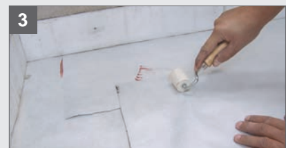
btf - Flexibel New - Feuchtigkeitssperre in den Kleber drücken und zusätzlich mit Andrückrolle fixieren
