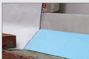
ELMCO – Sperrfolie-Vlies II, geprüfte 1 Befestigung am Hintermauerwerk
