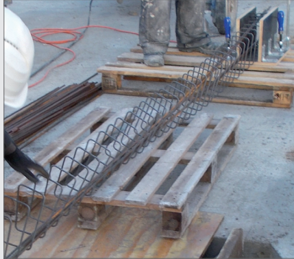
Auseinanderziehen und mit Längseisen verbinden
