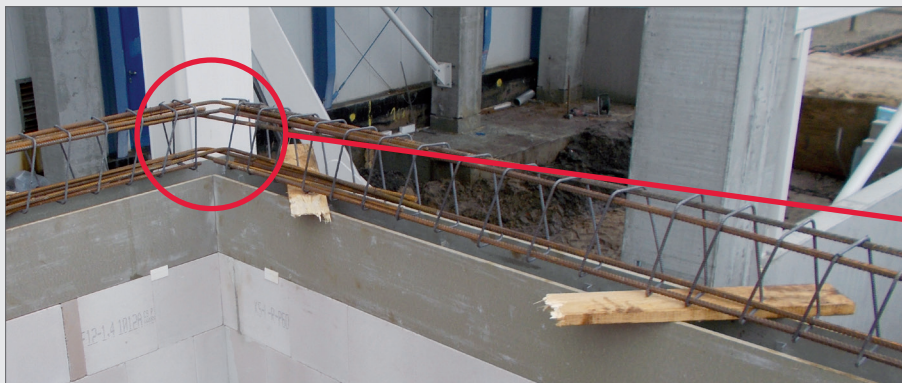
Ringanker- und Sturzbewehrung mit ELMCO – FeKo als Eckbewehrung
