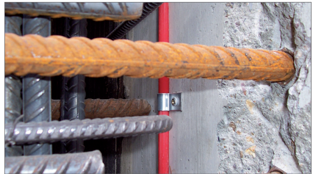
ELMCO – Vpress befestigt mit Schlauchschelle
