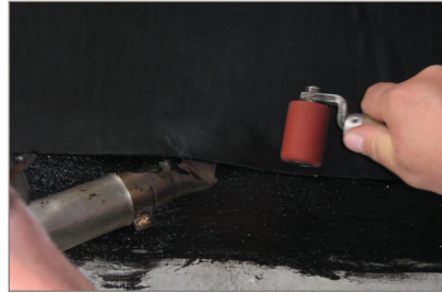
Randverschweißung mit Heißluftföhn
