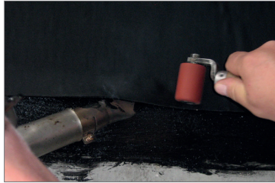
Randverschweißung mit Heißluftföhn
