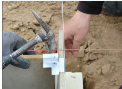
Verbinden der zementgebundenen Holz-faserplatten mit den Büsa
