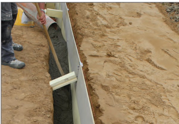
Streifenfundament lagenweise betonieren
