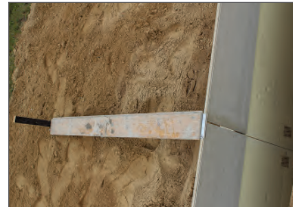
Zur lotgerechten Lagesicherung Anschrauben von Schalungsbrettern
