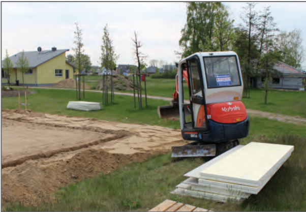
Aushub des Fundamentgrabens
