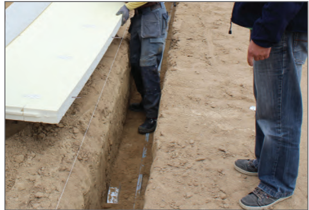
Abschnüren der Längsseiten
