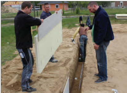
Elemente werden von oben in den Fundamentgraben gestellt und ausgerichtet
