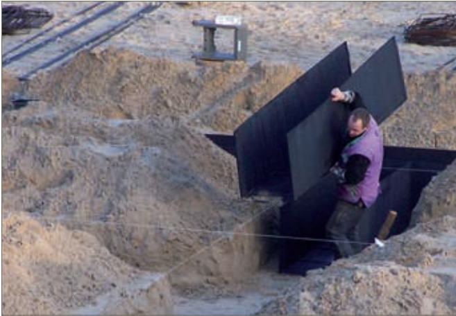
Örtliches Bewegen der Schalung ohne Maschineneinsatz
