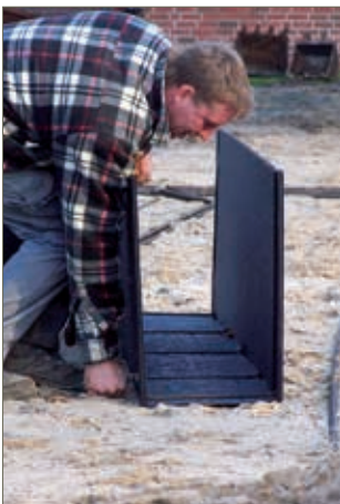
Ablängen vom Schalelement oder Anpassen an Ecken erfolgt mittels einer Cutter/Hakenklinge
