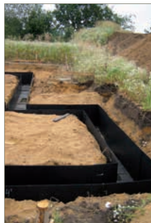
ELMCO–Form Typ FSS-U gefertigt nach Fundamentplan
