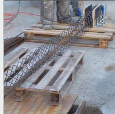
Auseinanderziehen und mit Längsseisen verbinden
