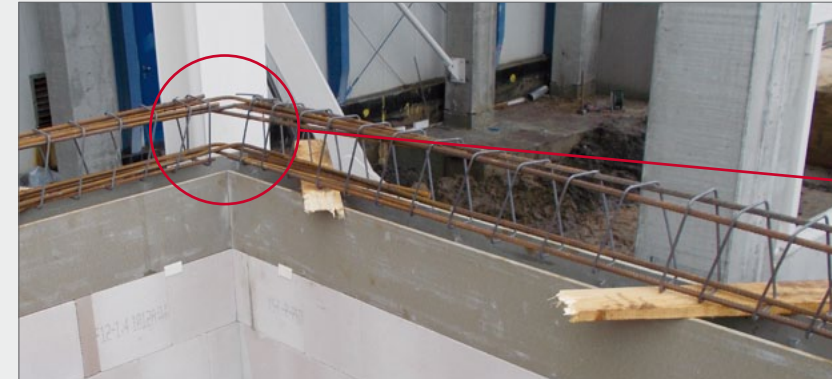
Ringanker- und Sturzbewehrung mit ELMCO–FeKo als Eckbewehrung
