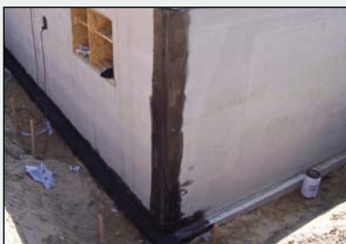
Abdichtung von Elementwänden
