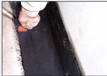
Verschweißen der Stöße und Ränder nach Einweisung vor Ort ohne zertifiziertes Fachpersonal möglich
