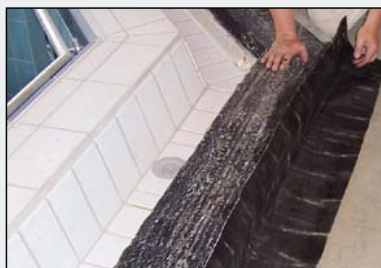
Abdichtung in einem Schwimmbad
